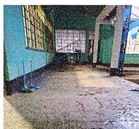
Foto 3: Sustrucción de piso pasillo frente a aulas. Foto 4: Sustrucción de piso pasillo frente a dirección.
