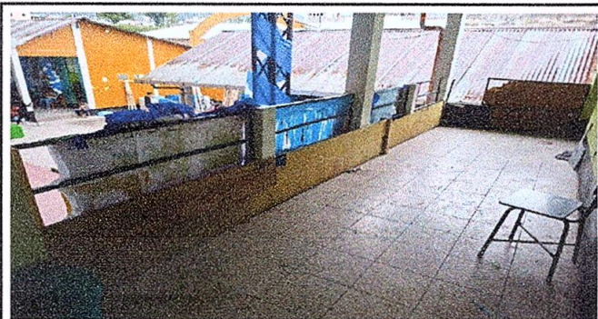
Foto 9: Sustitución de barandas de metal
