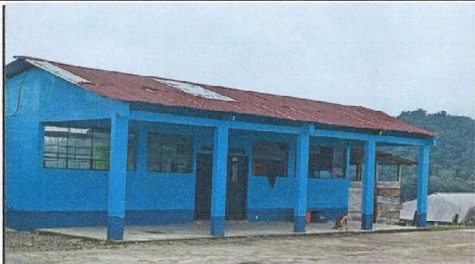
Foto1: Sustitución de lámina por lámina troquelada calibre 26.
