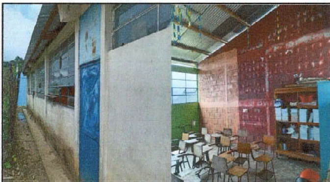
Foto 3: Pintura en muros exteriores e interiores.
