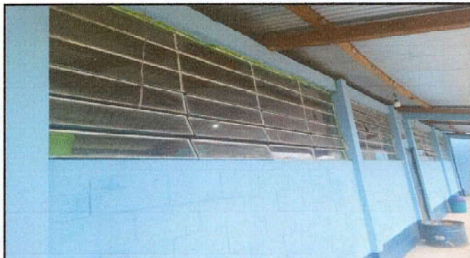
Foto 4: Sustitución de balcones de metal en ventanas.
