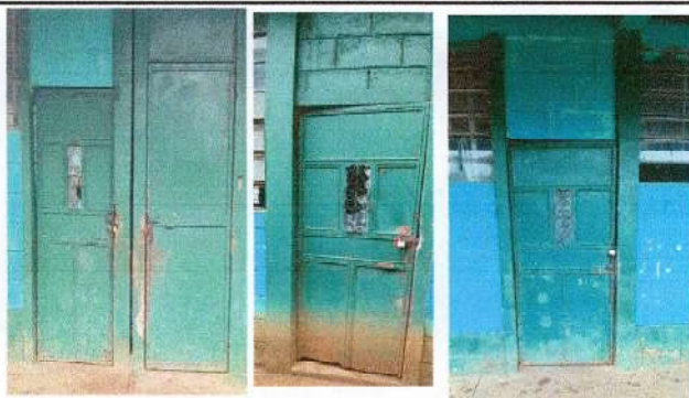
Foto 3: Sustrucción de puertas de metal deterioradas.
