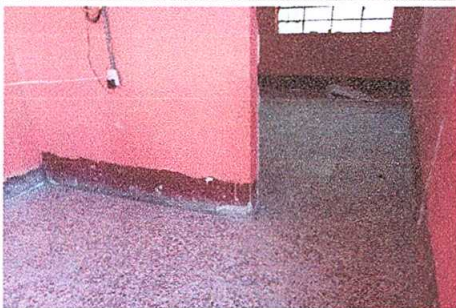
Foto 5: Sustitución de piso en mal estado
