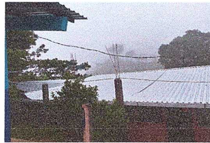
Foto 4: Sustitución de lámina acanalada y estructura de madera por lámina troquelada y estructura de metal
