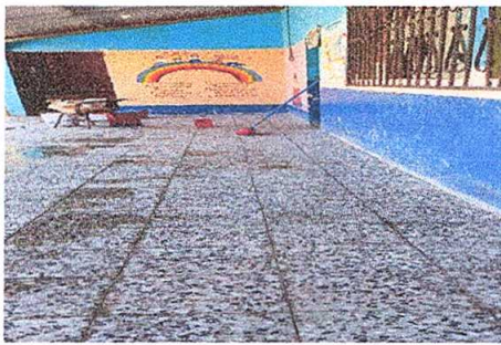
Foto 3: Sustitución de piso en mal estado
