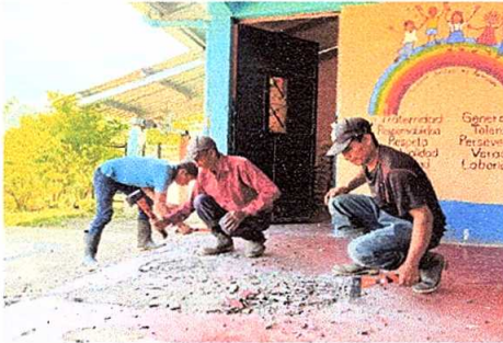
Foto 3: Sustitución de piso en mal estado
