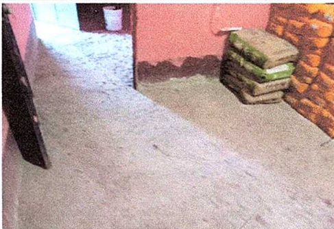
Foto 5: Sustitución de piso en mal estado
