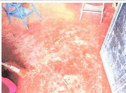
Foto 5: Sustitución de piso en mal estado
