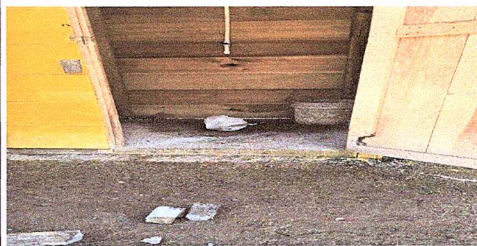
Foto 4: cambio de letrina a sanitario
