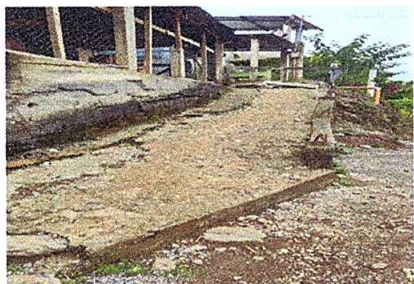
Foto 9: barandales en mal estado
