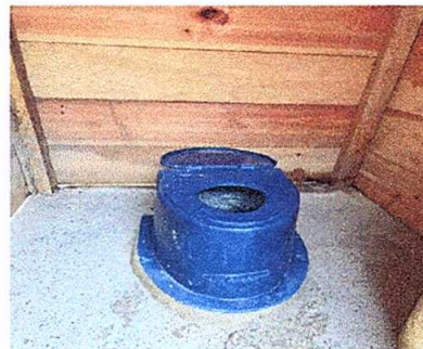
Foto 4: cambio de letrina a sanitario
