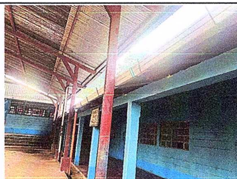
Foto 4: Canales y bajadas de agua pluvial
