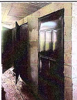
Foto 5: Sustitución de puertas de metal
