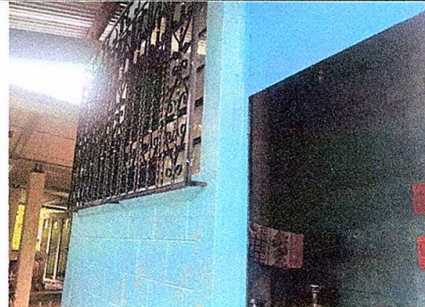
Foto 8: Reparación de cocina
