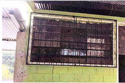
Foto 8: Reparación de cocina
