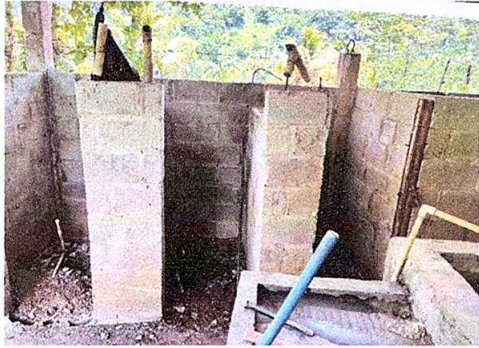
Foto7: Piso para baño
