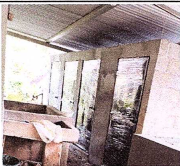
Foto 5: Sustitución de puertas de metal
