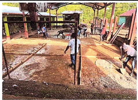
Foto 3: Losa de patio
