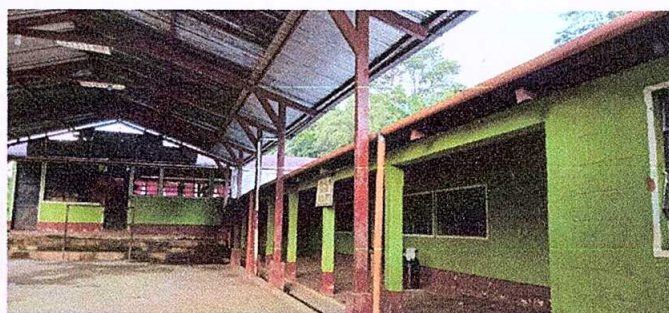
Foto 4: Canales y bajadas de agua pluvial
