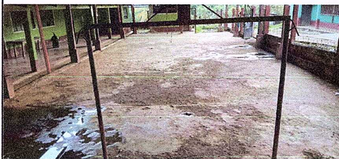
Foto 3: losa del patio
