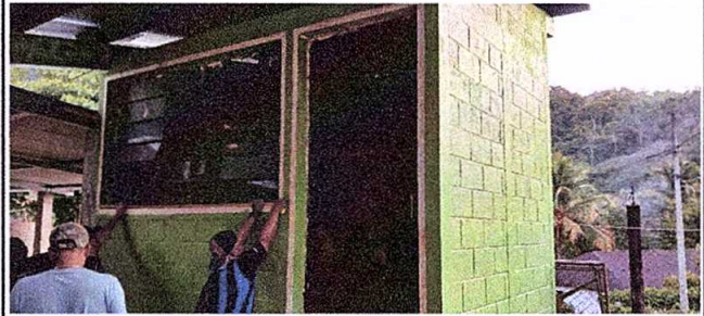
Foto 8: Reparación de cocina
