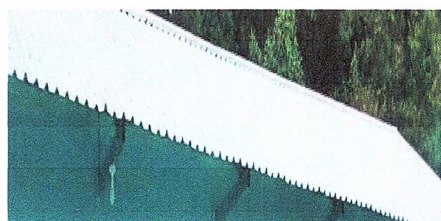
Foto 5 : Sustitucion de lamina por lámina troquelada aluzinc
