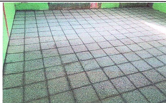
Foto 4: Reparacion de piso de torta de concreto
