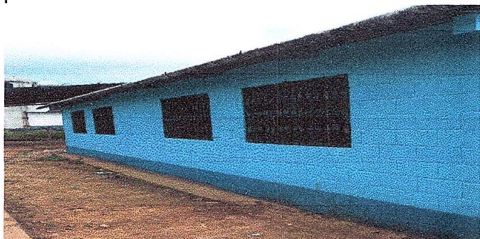
Foto1: pintura de muros interiores y exteriores
