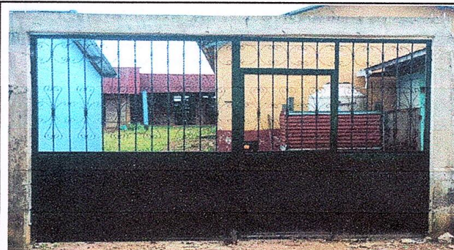
Foto 2: Sustitucion de portón de madera por metal
