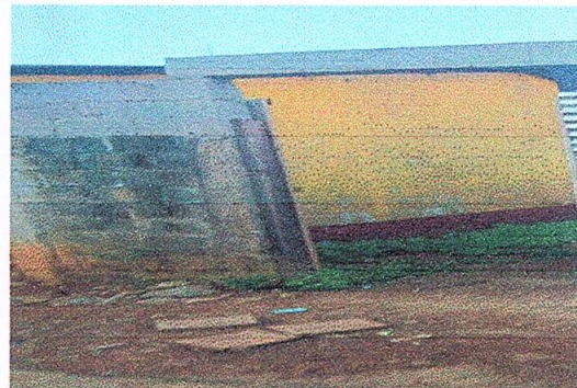
Foto 2: Sustitucion de portón de madera por metal
