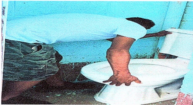
Foto 7: Sustitucion de inodoro
