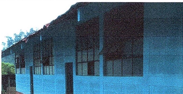
Foto1: pintura de muros interiores y exteriores
