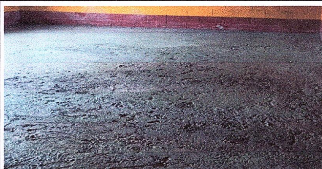
Foto 4: Reparacion de piso de torta de concreto
