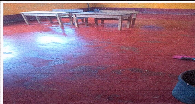
Foto 4: Reparación de piso de torta de concreto
