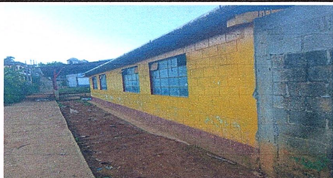
Foto 1: Pintura de muros interiores y exteriores
