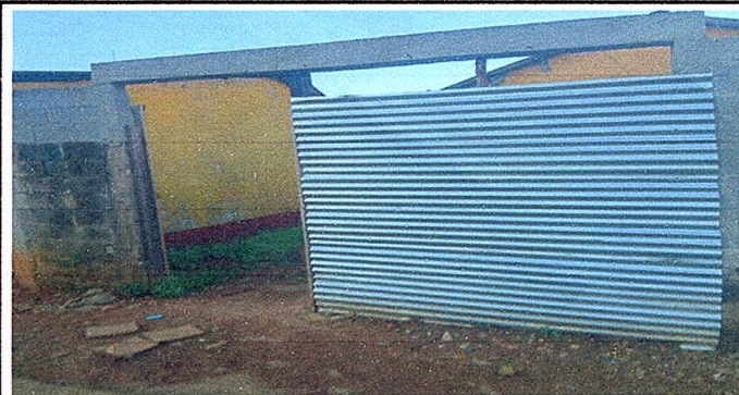
Foto 2: Sustitución de portón de madera por metal
