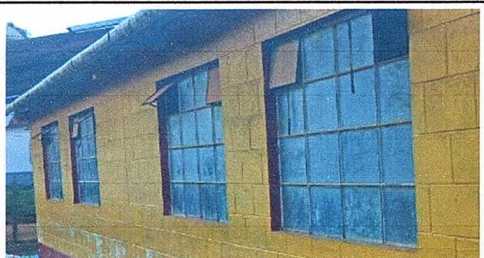
Foto 3: Sustitución de vidrios
