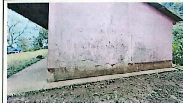
Foto 6: Pintura en muros exteriores e interiores
