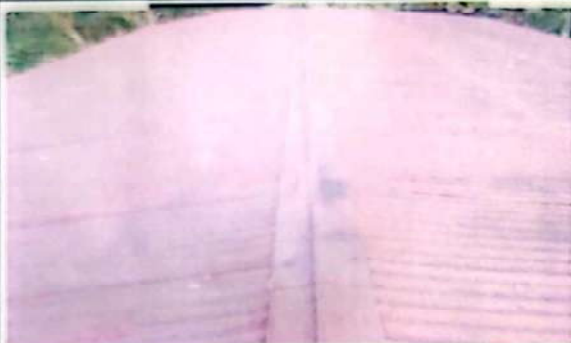
Foto 1: Sustrucción de lámina, por lámina troquelada aluzinc calibre 26
