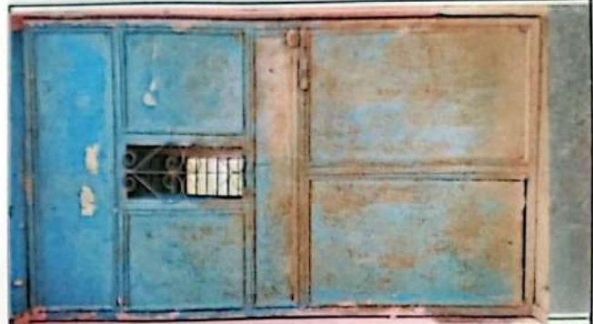
Foto 2: Sustrucción de puertas
