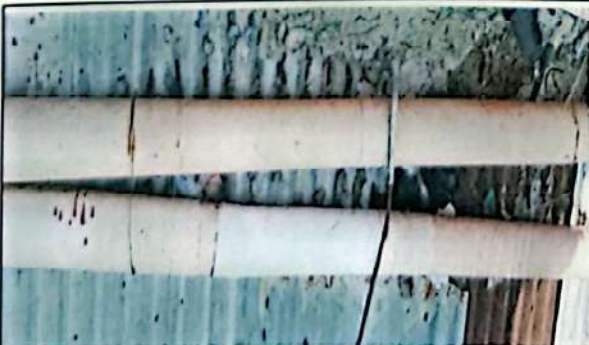
Foto 5: Sustrucción de bajada de agua pluvial de metal por tubo PVC 3
