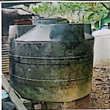
Foto 7: Sustitución de depósito de agua 2500 Lt
