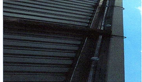
Foto 6: Sustrucción de canal de pvc.
