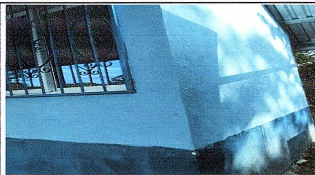
Foto 10: Repello en muro.
