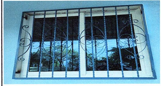
Foto 4: Sustrucción de ventanas de madera por material de pvc más vidrio.
