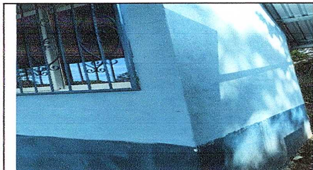
Foto 7: Pintura en muros exteriores e interiores.
