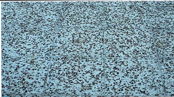
Foto 5: Sustrucción de piso de granito.
