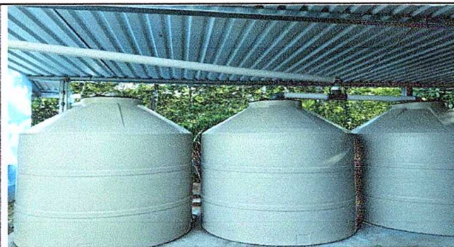
Foto 8: Sustitución de depósito de agua 2500 lt.
