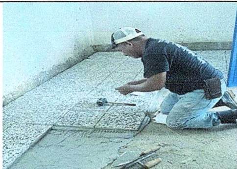
Foto 5: Sustitución de piso de granito.
