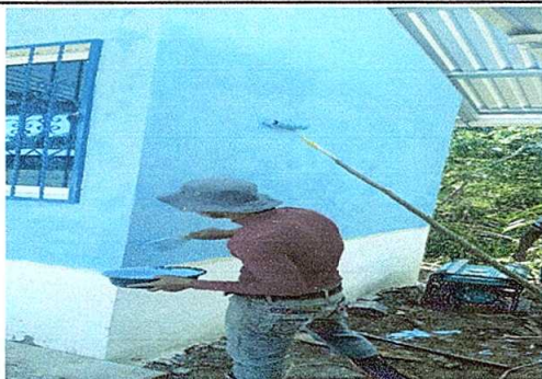
Foto 7: Pintura en muros exteriores e interiores.
