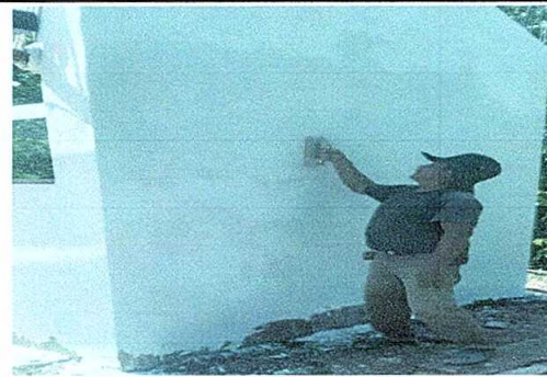
Foto 10: Repello en muro.
