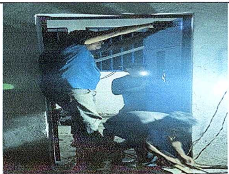
Foto 3: Sustitución de puerta (2.10 m de alto * 90 cm de ancho).
