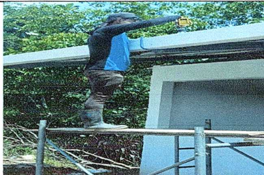
Foto 6: Sustitución de canal de pvc.
