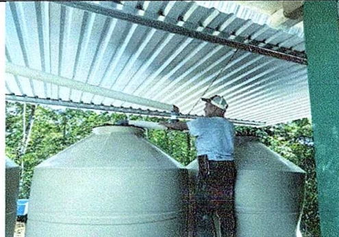
Foto 8: Sustitución de depósito de agua 2500 lt.
