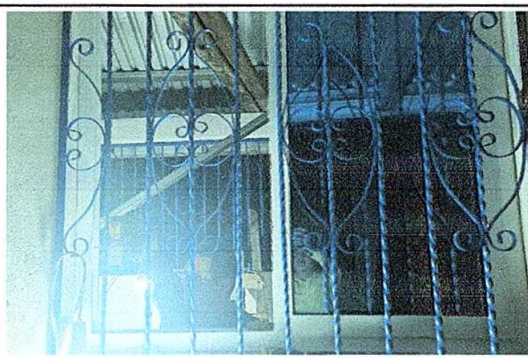
Foto 4: Sustitución de ventanas de madera por material de pvc más vidrio.
