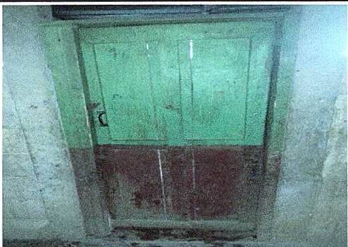
Foto 3: Sustitución de puerta (2.10 m de alto * 90 cm de ancho).
