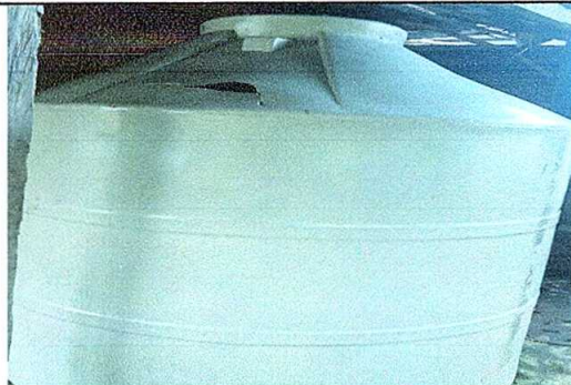
Foto 8: Sustitución de depósito de agua 2500 lt.
