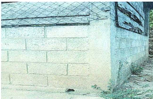
Foto 7: Pintura en muros exteriores e interiores.
