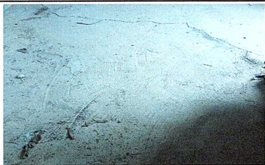
Foto 5: Sustitución de piso de granito.
