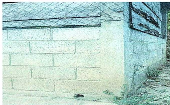
Foto 10: Repello en muro.
