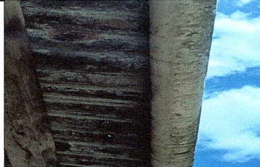
Foto 6: Sustitución de canal de pvc.
