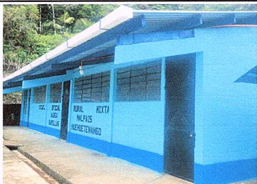
Foto 3: Pintura en muros exteriores e interiores
