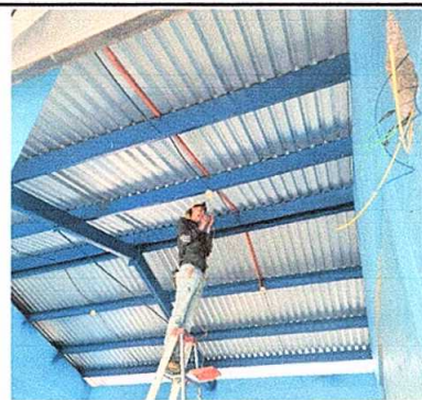
Foto 6: Reparación del sistema eléctrico
