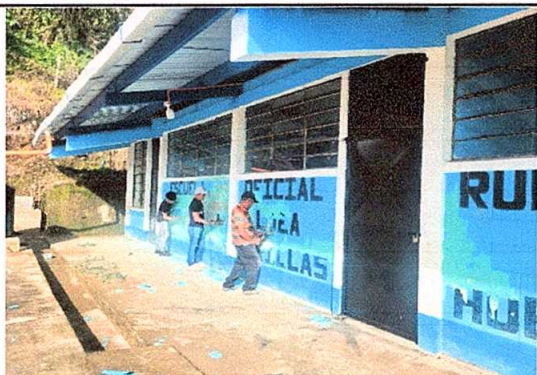
Foto 3: Pintura en muros exteriores e interiores
