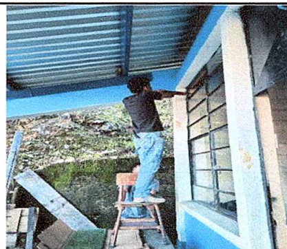
Foto 6: Vidrios de ventanas faltantes
