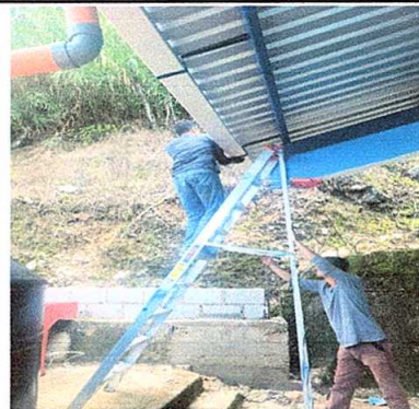
Foto 2: Canales y bajadas de agua en malas condiciones
