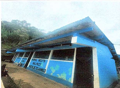
Foto 9: Pintura en muros exteriores e interiores
