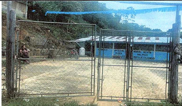
Foto 5: Porton en malas condiciones
