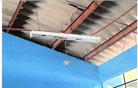
Foto 12: Reparación del sistema eléctrico
