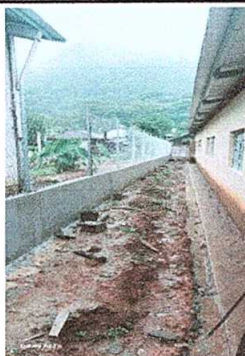
FOTO No. 5: Reparación de tubo hg y malla galvanizada
