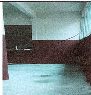
FOTO No. 4: Sustrucción de piso de torta de concreto
