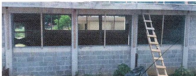
FOTO No. 3: Sustrucción de balcones de metal (1.35m de alto * 2.73m de ancho)
