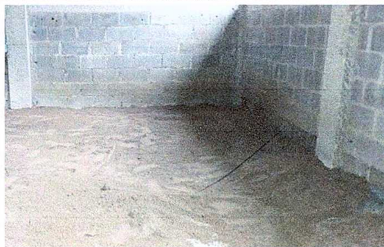
FOTO No. 4: Sustrucción de piso de torta de concreto
