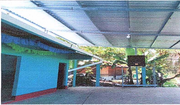
Foto 1: Cubierta de lamina
