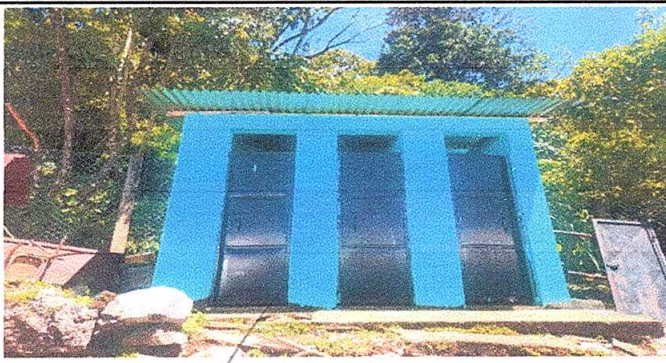
Foto 3: Sustitucion de puertas de metal y porton de matal
