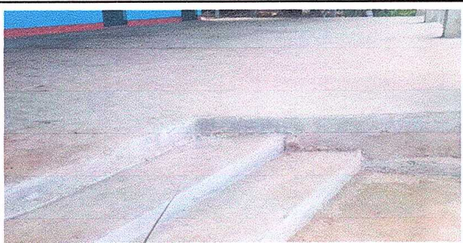
Foto 5: Sustitucion de piso de torta de concreto
