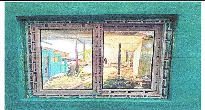
Foto 4: sustitucion de ventana a PVC 1.08 altura por 1.80 de ancho
