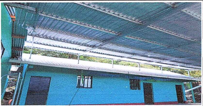
Foto 6: Canales y bajadas de agua pluvial
