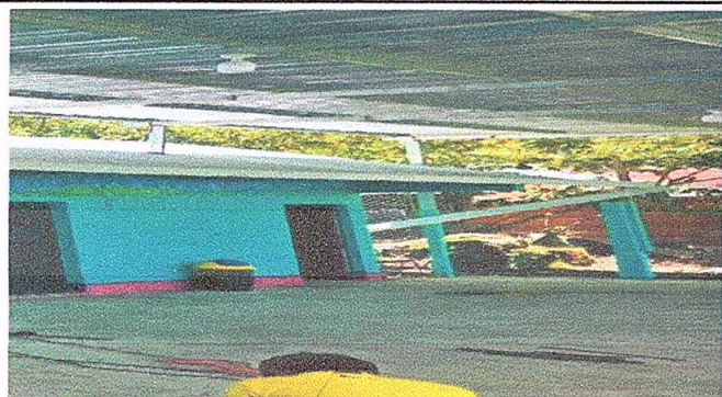
Foto 1: Cubierta de lamina
