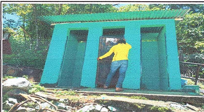
Foto 3: Sustitucion de puertas de metal y porton de metal
