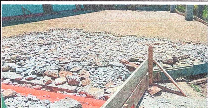
Foto 5: Sustitucion de piso de torta de concreto
