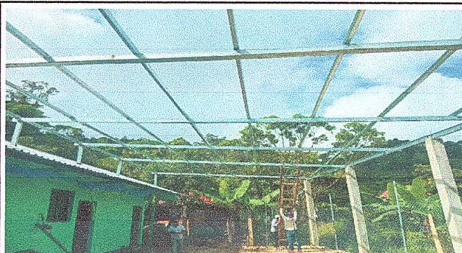
Foto 2: Estructura de techo
