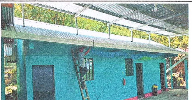
Foto 6: Canales y bajadas de agua pluvial
