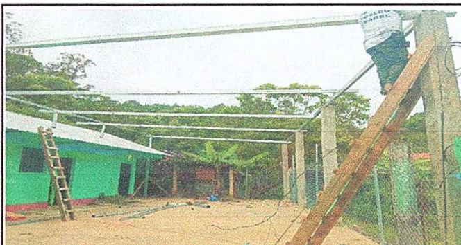
Foto 6: Mejoramiento lámina y estructura de techo
