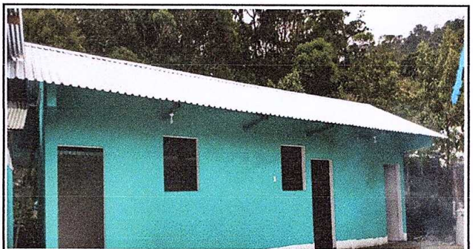
Foto 6: Canales y bajadas de agua pluvial
