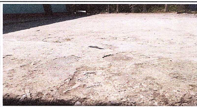
Foto 5: Sustitucion de piso de torta de concreto
