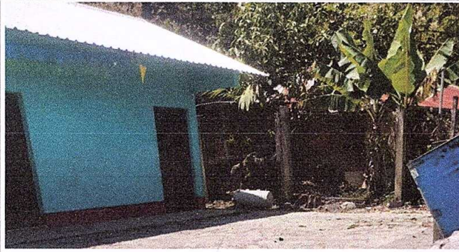
Foto 1: Cubierta de lamina
