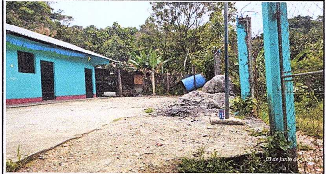
Foto 2: Estructura de techo
