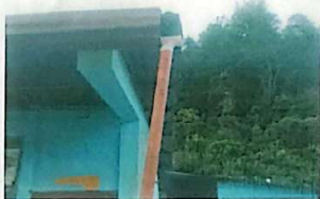
Foto 5: REPARACIÓN DE BAJADA DE AGUA PLUVIAL, A TUBO PVC 3"
