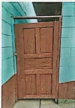
Foto 3: SUSTITUCIÓN DE PUERTA EN SERVICIO SANITARIO
