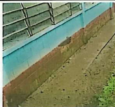
Foto 6: PINTURA EN MUROS EXTERIORES E INTERIORES
