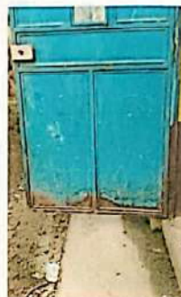
Foto 2: SUSTITUCION DE PUERTAS
