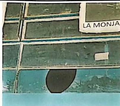
Foto 4: SUSTITUCIÓN DE VENTANAS
