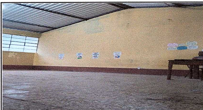
Foto 3: Sustitucion de piso de granito
