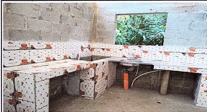
Foto 2: Reparacion de cocina
