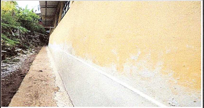
Foto 2: Reparacion de de repello y cernido
