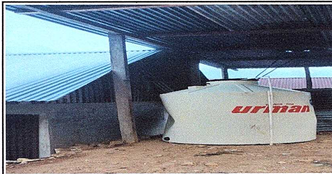
Foto 6: Depósito de agua en buen estado
