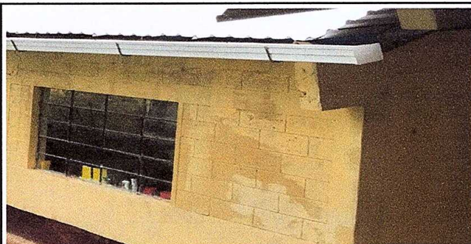
Foto 5: Canaletas instaladas
