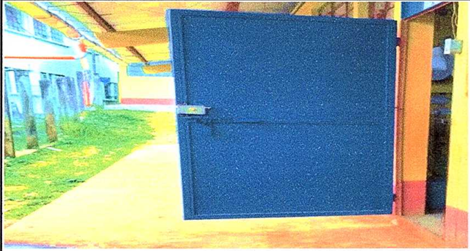
Foto 1: Aplicación de pintura en puertas
