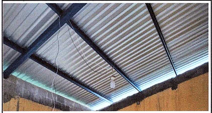
Foto 4: Sustituyendo cables y focos nuevos
