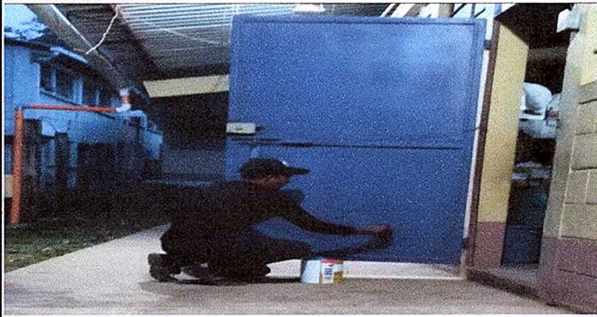
Foto1: sustituyendo pintura de puertas
