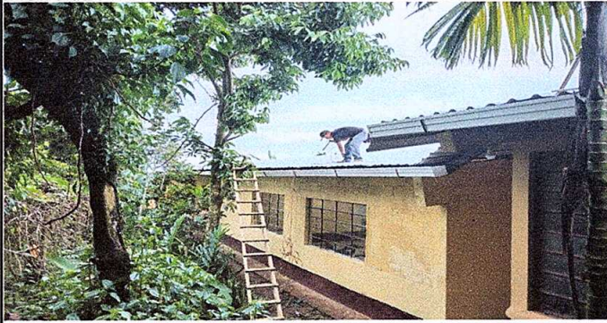
Foto1: Colocacion de laminas nuevas
