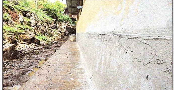
Foto 2: Sustituyendo repello y cernido
