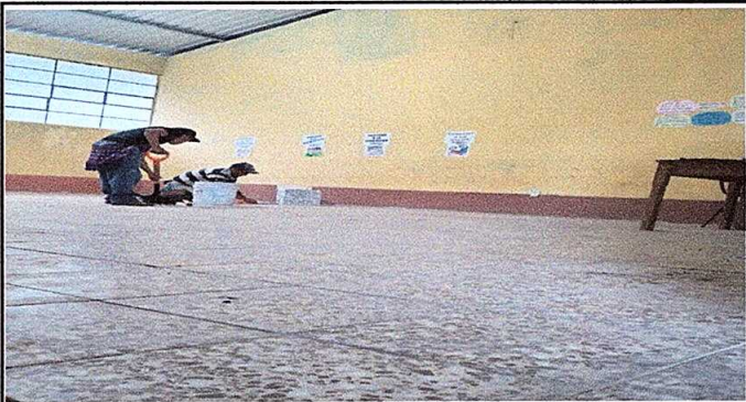
Foto 3: Sustituyendo el piso
