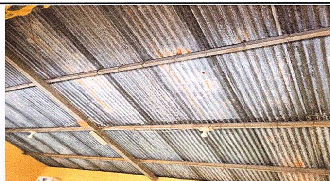
Foto 4: Focos y cables que no funcionan
