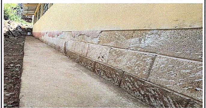
Foto 2: Reparacion de repello y cernido en paredes
