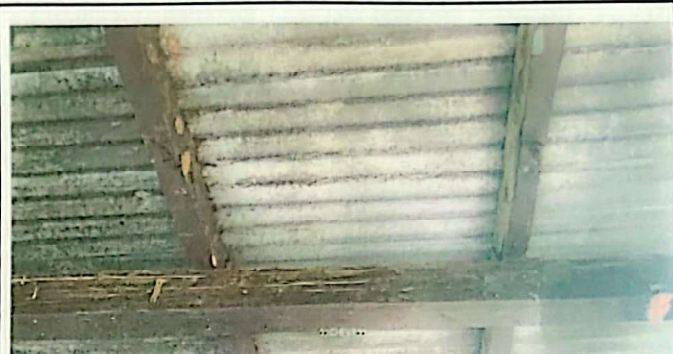
Sustitución de soporte de madera por metal
