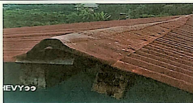
Sustitución de capote de lamina por capote de lámina troquelada
