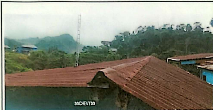
sustitución de lámina por lámina troquelada
