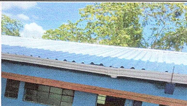
Foto 4: sustrucción de canales de pvc
