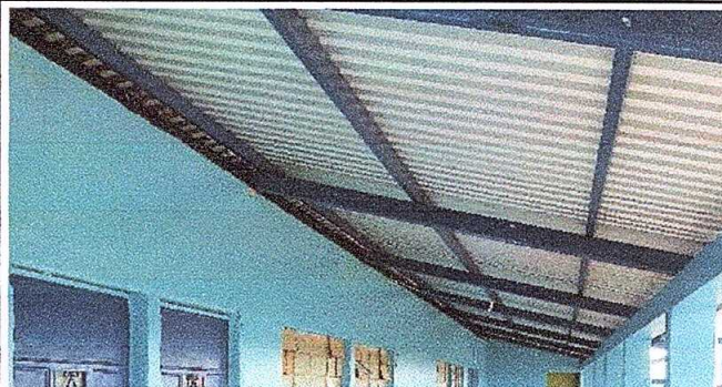
Foto 2: Sustrucción de estructura de soporte de madera
