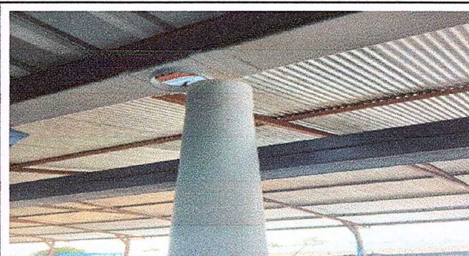
Foto 4: Sustitución de canales de pvc
