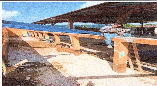
Foto 2: sustitución de estructura de soporte de madera
