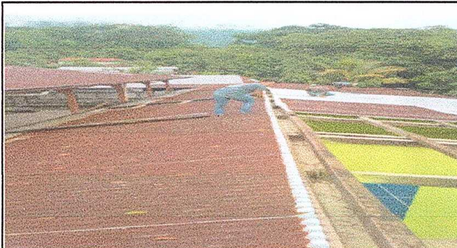
Foto 1: sustitución de lámina
