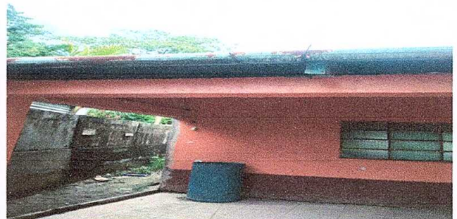
Foto 4: Sustrucción de canales de pvc
