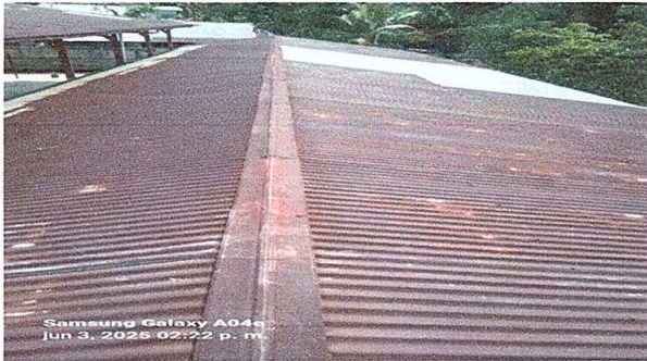
Foto1: Sustrucción de lamina
