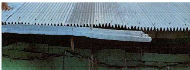
SUSTITUCIÓN POR CANALES DE METAL
