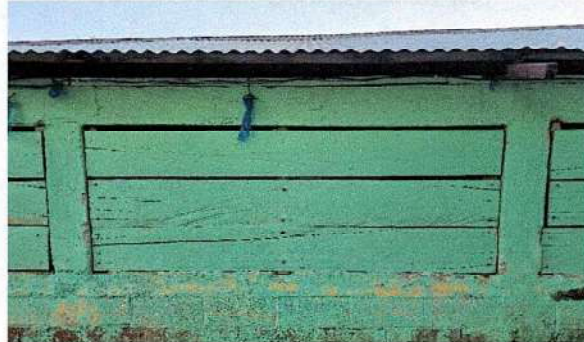
COLOCACIÓN DE BLOCK
