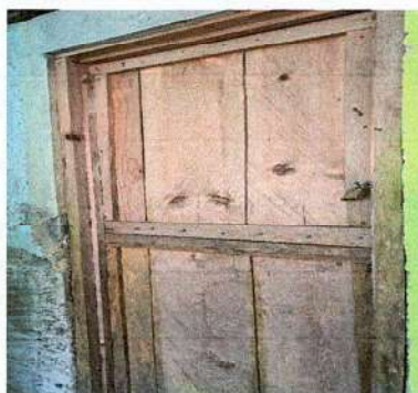
SUSTITUCIÓN POR PUERTA DE METAL
