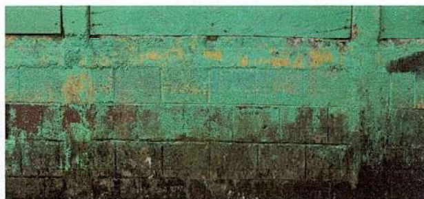
REPELLO DE AULAS
