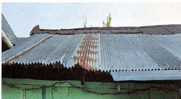
SUSTITUCIÓN POR LÁMINA TROQUELADA
