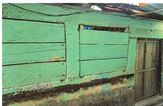
SUSTITUCIÓN POR VENTANAS DE METAL
