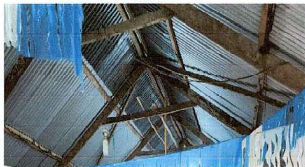
SUSTITUCIÓN POR ESTRUCTURA DE METAL
