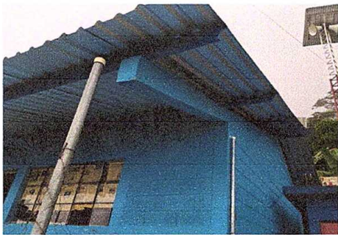
Foto 9: Estructura de techo: mantenimiento a estructura de soporte de metal.
