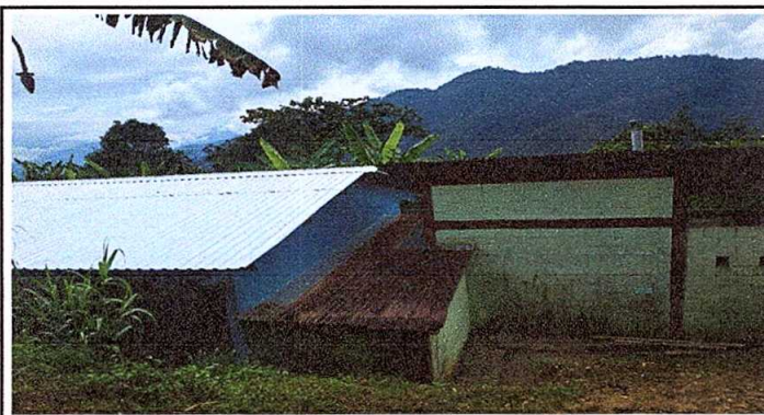
Foto 1: Sustitución de lámina, por lámina troquelada aluzinc calibre 26, sustitución de capote de lámina para lámina troquelada y sustitución de elementos de fijación.
