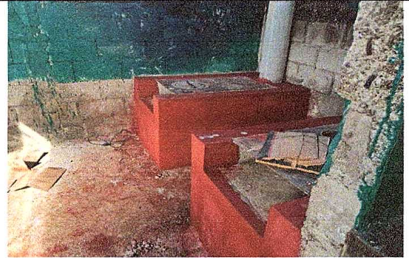
Foto 8: reparacion de cocina. Sustitución de planchas de metal
