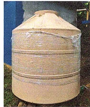
Reparación y mantenimiento de sisternas/depositos de agua: sustitución de deposito de agua 2500 lt
