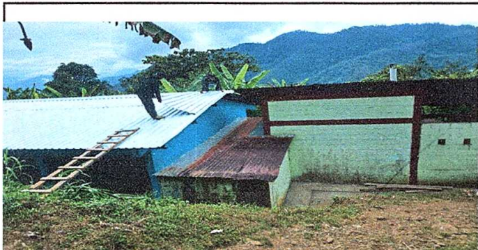
foto 1: Sustrucción de lámina, por lámina troquelada aluzinc calibre 26, sustrucción de capote de lámina para lámina troquelada y sustrucción de elementos de fijación.
