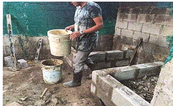
Foto 8: reparacion de cocina. Sustitución de planchas de metal
