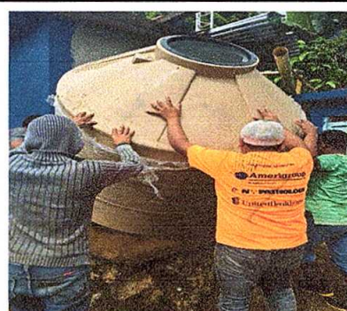
Reparación y mantenimiento de sisternas/depositos de agua: sustitución de deposito de agua 2500 lt
