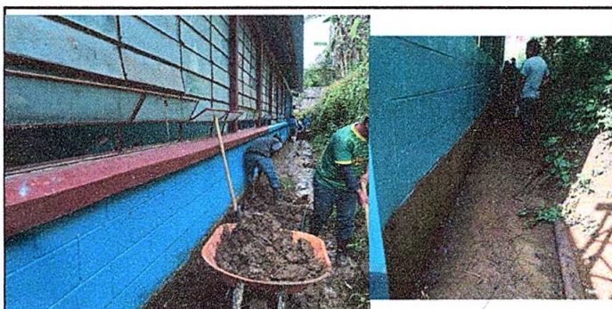
Foto 6: cuneta de concreto: Es necesaria la reparación de la cuneta de concreto
