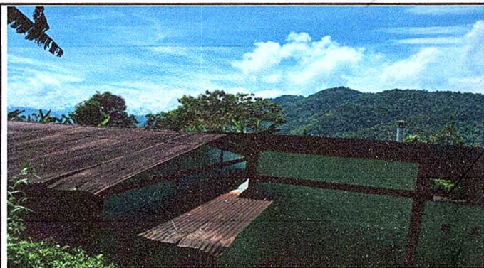
Foto 1: Sustrucción de lámina, por lámina troquelada aluzinc calibre 26, sustrucción de capote de lámina para lámina troquelada y sustrucción de elementos de fijación.
