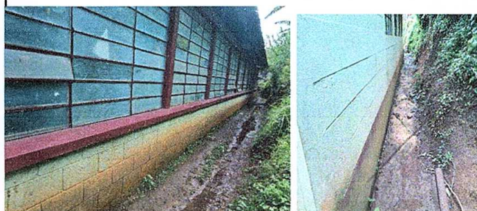
Foto 6: cuneta de concreto: Es necesaria la reparación de la cuneta de concreto
