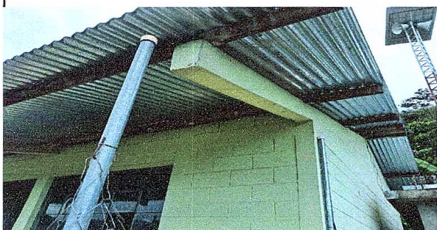
Foto 9: Estructura de techo: mantenimiento a estructura de soporte de metal.
