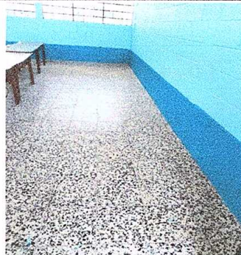
FOTO No. 2: Sustrucción de piso de granito.
