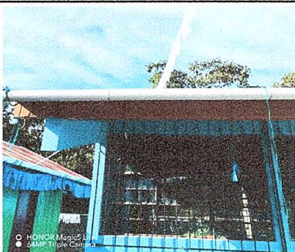
FOTO No. 3: Mejoramiento de soporte o pescante de PVC para canal.
