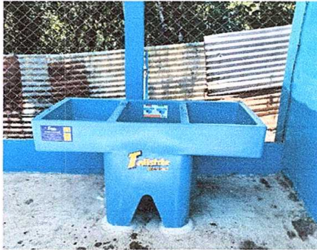
FOTO No. 7: Sustitución de pila plástica de dos lavaderos.
