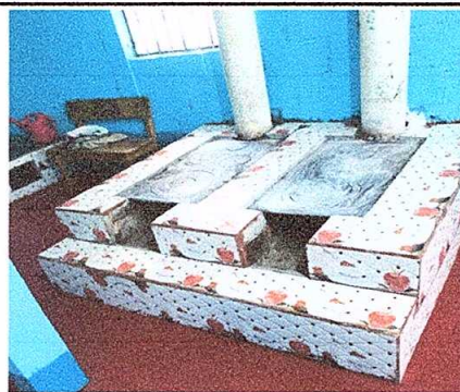
FOTO No. 6: Instalación de azulejo en estufa rural.
