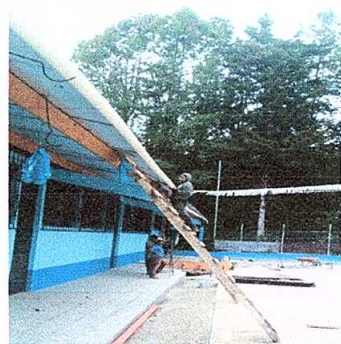
FOTO No. 3: Mejoramiento de soporte o pescante de PVC para canal.
