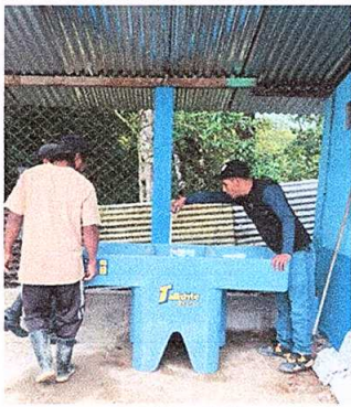
FOTO No. 7: Sustitución de pila plástica de dos lavaderos.
