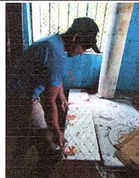
FOTO No. 6: Instalación de azulejo en estufa rural.
