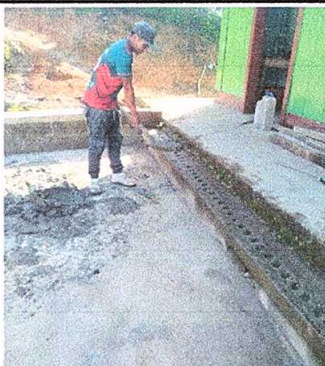
FOTO No. 1: Sustitución de piso de torta de concreto.
