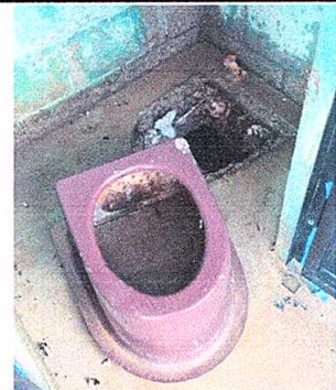
FOTO No. 5: Sustitución de inodoro.
