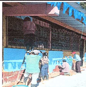
FOTO No. 4: Pintura en muros exteriores e interiores.
