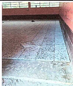
FOTO No. 2: Sustitución de piso de granito.
