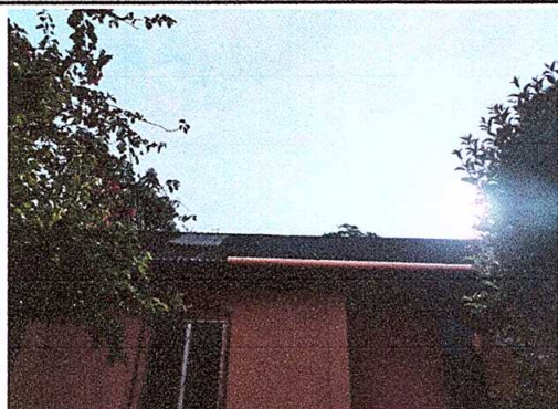
FOTO No. 3: Mejoramiento de soporte o pescante de PVC para canal.
