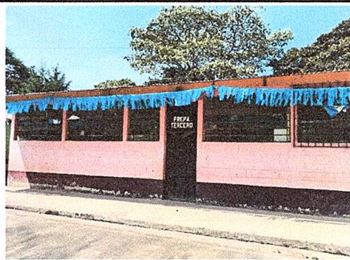
FOTO No. 4: Pintura en muros exteriores e interiores.
