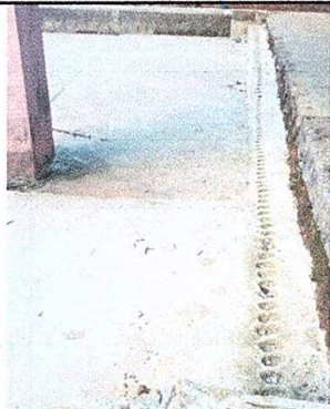
FOTO No. 1: Sustrucción de piso de torta de concreto.
