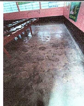
FOTO No. 2: Sustrucción de piso de granito.
