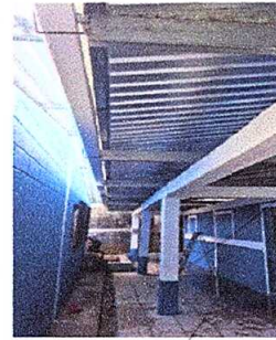
Foto 4: Sustrucción de canal de PVC
