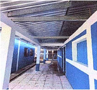
Foto 3: sustrucción de estructura de soporte de madera por metal
