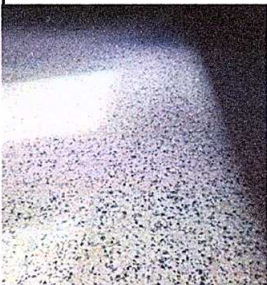
Foto 5: sustrucción de piso de granito
