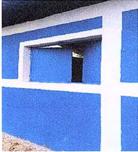
Foto 1: Sustrucción de estructura de metal de ventana
