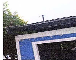
Foto 6: Sustrucción de lámina por lamina troquelada alizinc calibre 26
