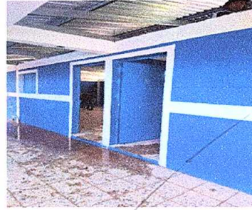
Foto 2: Sustrucción de puertas
