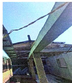
Foto 4: Sustrucción de canal de PVC
