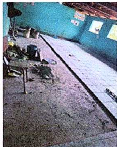
Foto 5: sustitución de piso de granito
