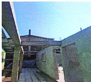
Foto 3: sustitución de estructura de soporte de madera por metal
