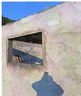
Foto 1: Sustrucción de estructura de metal de ventana
