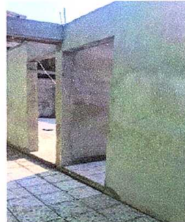
Foto 2: Sustrucción de puertas
