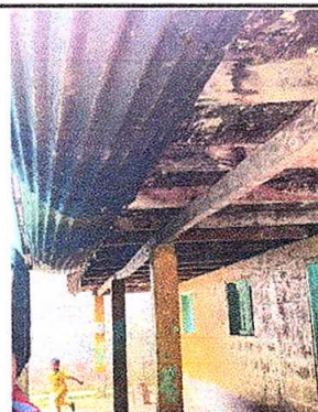
Foto 4: Sustrucción de canal de pvc
