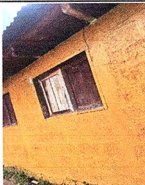
Foto 1: Sustrucción de estructura de metal de ventana (1m * 1.30m)(10 ventanas)
