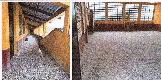
Foto 2: Sustitución de piso de torta por piso de granito en aulas y corredor.
