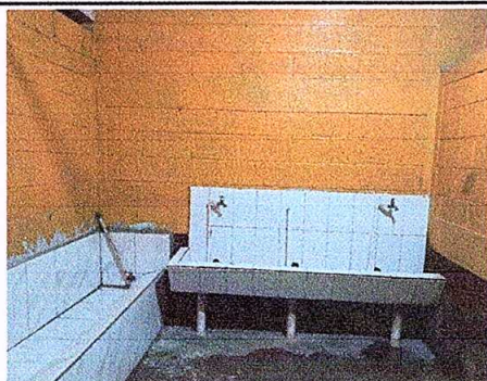
Foto 5: Mejoramiento de Mingitorio
