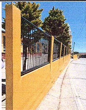
Foto 3: Reparacion de muro perimetral.
