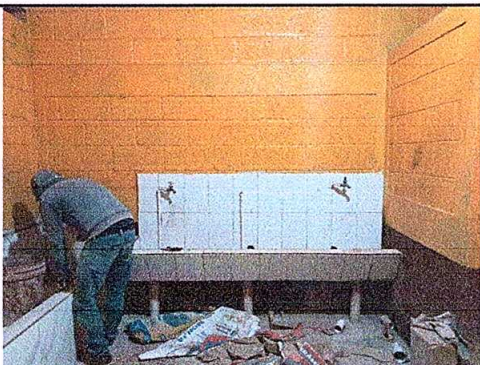
Foto 5: Mejoramiento de Mingitorio
