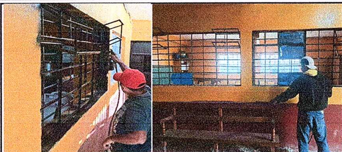
Foto1: Sustitución de vidrios y mantenimiento a estructuras
