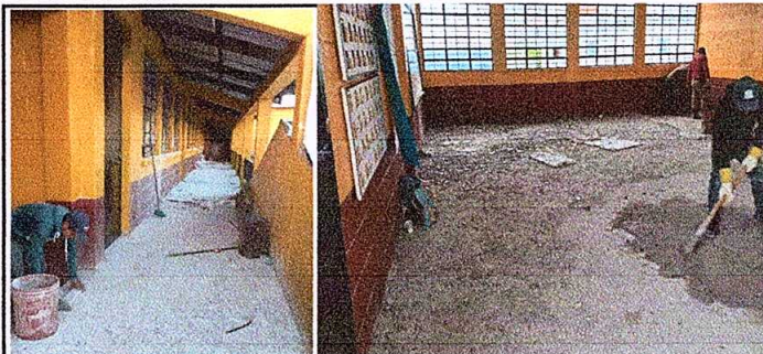
Foto 2: Sustitución de piso de torta por piso de granito en aulas y corredor.
