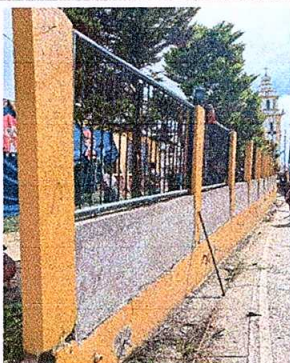
Foto 3: Reparación de muro perimetral.
