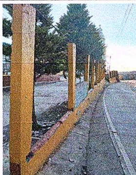
Foto 3: Reparación de muro perimetral.
