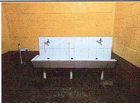
Foto 5: Mejoramiento de Mingitorio
