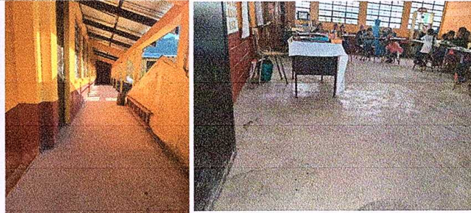
Foto 2: Sustitución de piso de torta por piso de granito en aulas y corredor.
