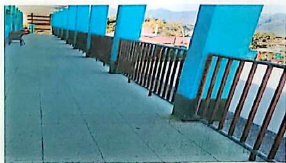
Foto 5: Mantenimiento a barandas de metal (aplicación de pintura)
