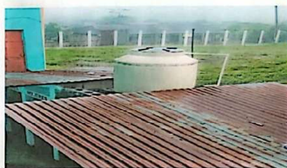
Foto 2: Sustitución de tinaco de 2,500 litros
