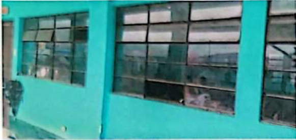
Foto 7: Sustrucción de balcones de metal color negro
