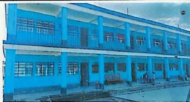
Foto 6: Mantemiento de paredes interiores y exteriores (pintura)
