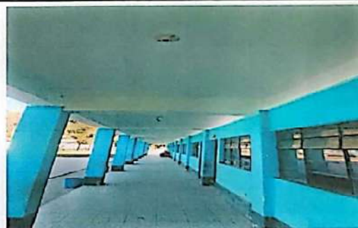
Foto 4: Sustitución de focos ahorradores de 50 watz.
