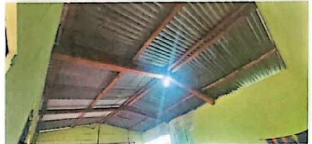
Foto 9: Sustrucción de de soporte de madera por metal.
