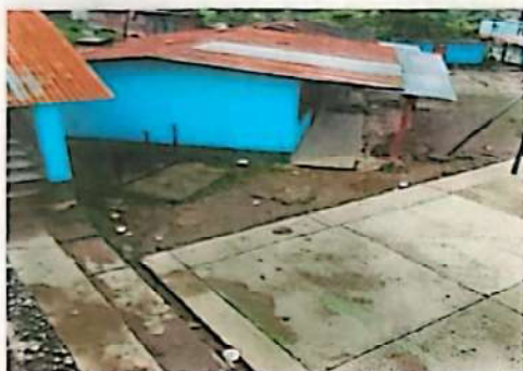
Foto 1: Sustitución de lámina por lámina troquelada
