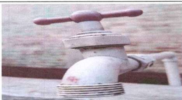
Foto 17: Sustitución de llave de chorro
