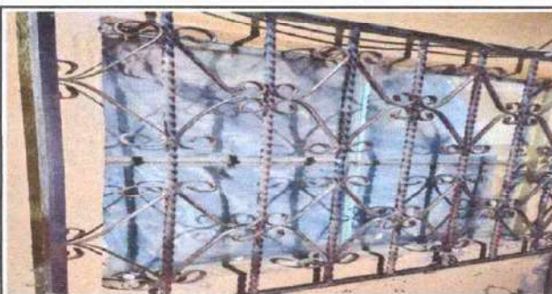
Foto 6: Sustrucción de ventana y Sustrucción de balcón
