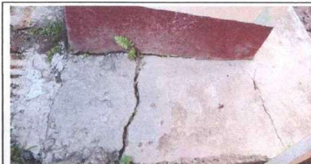
Foto 18: Reparación de piso de concreto
