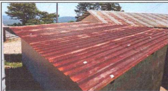
Foto 1: Sustrucción de lámina por lámina troquelada
