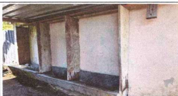
Foto 12: Sustrucción de mingitorio
