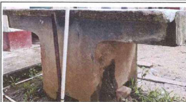
Foto 14: Sustitución de pila de cemento de concreto
