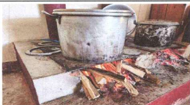
Foto 15: Sustitución de planchas de metal de 3 hornillas
