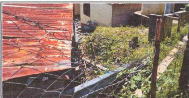
Foto 13: Reparación de malla galvanizada y alambre de pua
