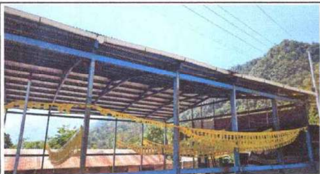
Foto 7: Sustrucción de canal de metal
