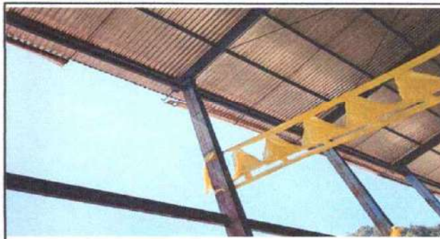
Foto 8: Sustrucción de tubo pvc
