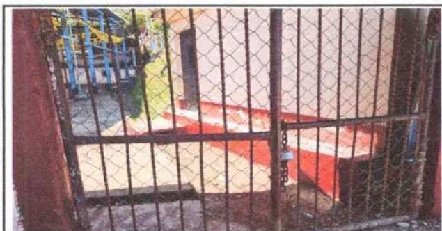
Foto 5: Sustrucción de porton de metal
