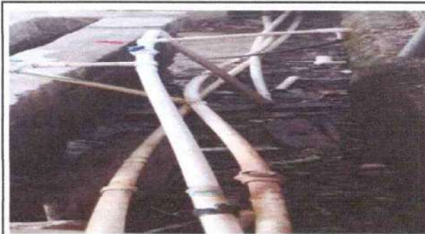
Foto 16: Reparación de red de drenaje y sustitución de tubería de línea principal
