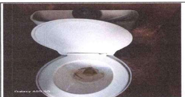
Foto 11: Sustrucción de inodoro
