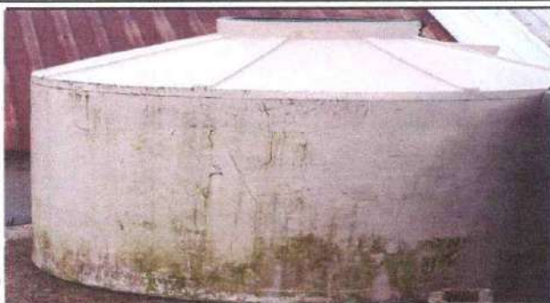
Foto13: Sustitución de depósito de agua de 2500 litros
