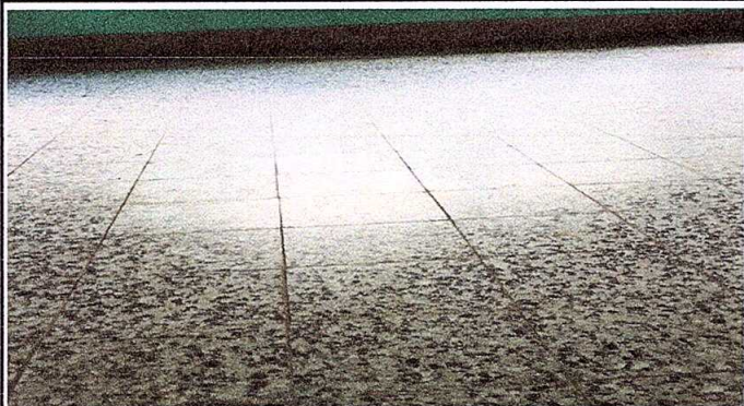
Foto 1: Sustitución de piso de granito
