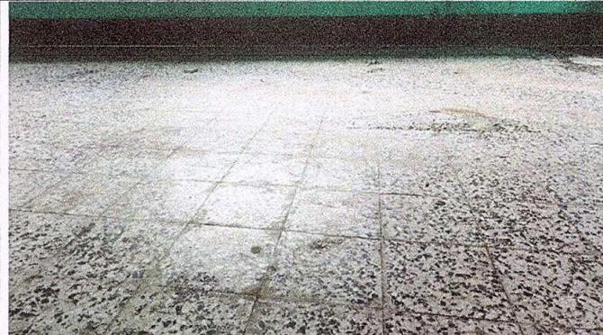
Foto 2: Sustitución de piso de granito
