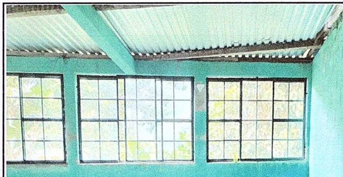
Foto 6: Pintura de muros exteriores
