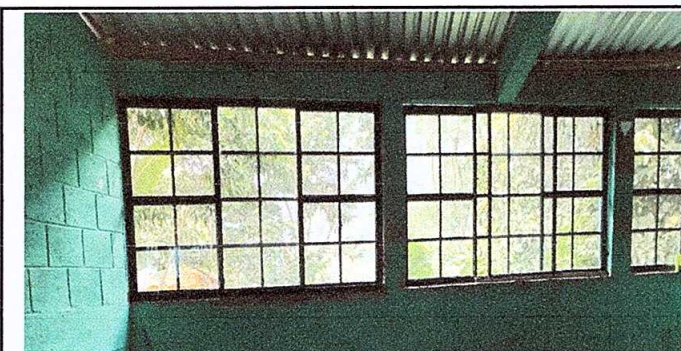
Foto 5: Sustitución de ventans de madera por metal más vidrio 2.34 X1.70
